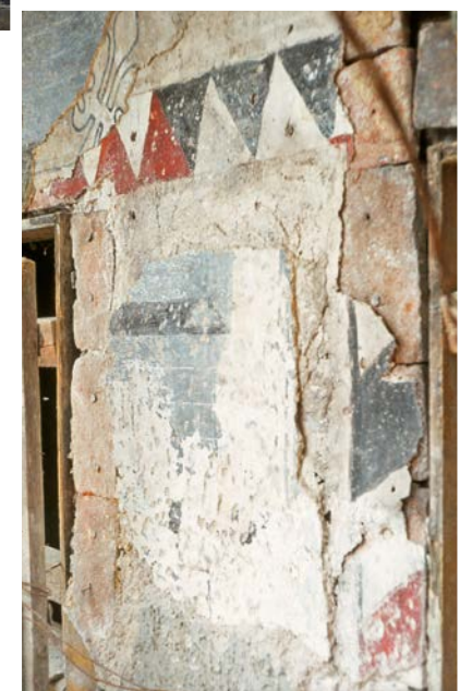
Freigelegt: Die drei ältesten Schichten und die darunterliegenden Ziegelplatten, die auf die Holzkonstruktion aufgenagelt waren (Foto: BLfD, Richard Strobel)
