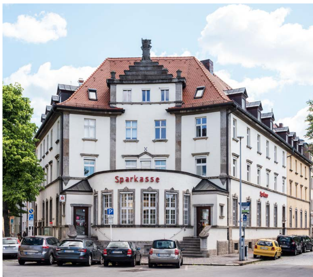
Ehemalige Stadtsparkasse Bamberg, Dr.-von-Schmitt-Straße 2, Kunigundendamm 7, Ansicht von Westen (Foto: BLfD, David Laudien)
