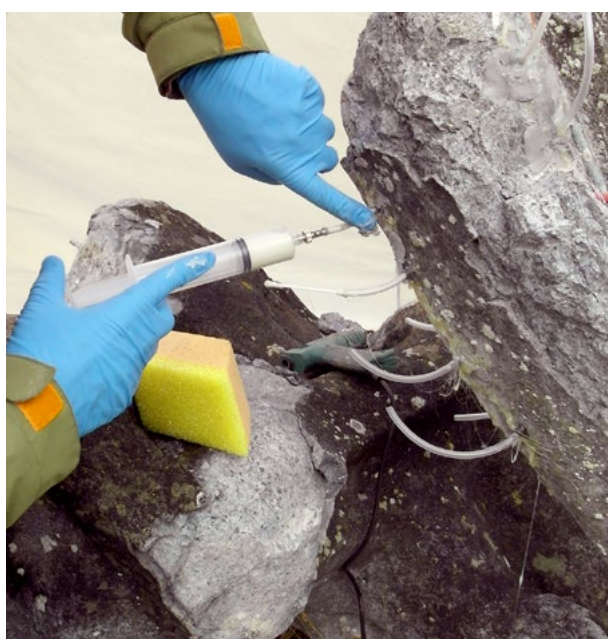
Rissinjektion (Foto: BLfD, Christoph Sabatzki)
