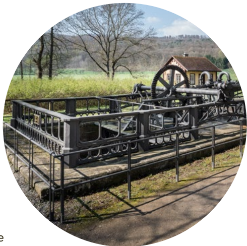
Pumpwerk zum Heben von Sole von 1848 und 1883 (Hauspumpe im Hintergrund) (Foto: BLfD, David Laudien)
