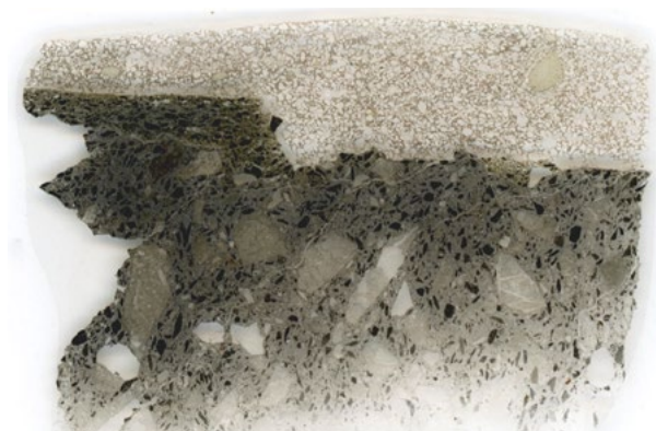
Dünnschliff: Inhomogene Kornverteilung mit Kalkstein- und Tonstein-Splitt, oben liegt ein Reparaturmörtel mit feineren Zuschlagskörnern (Foto: BLfD, Christoph Sabatzki)
