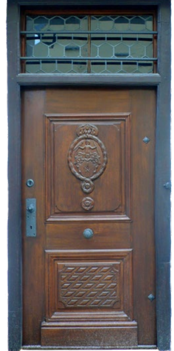
Historische Eingangstüre nach der Restaurierung (Foto: Eva Willberg)
