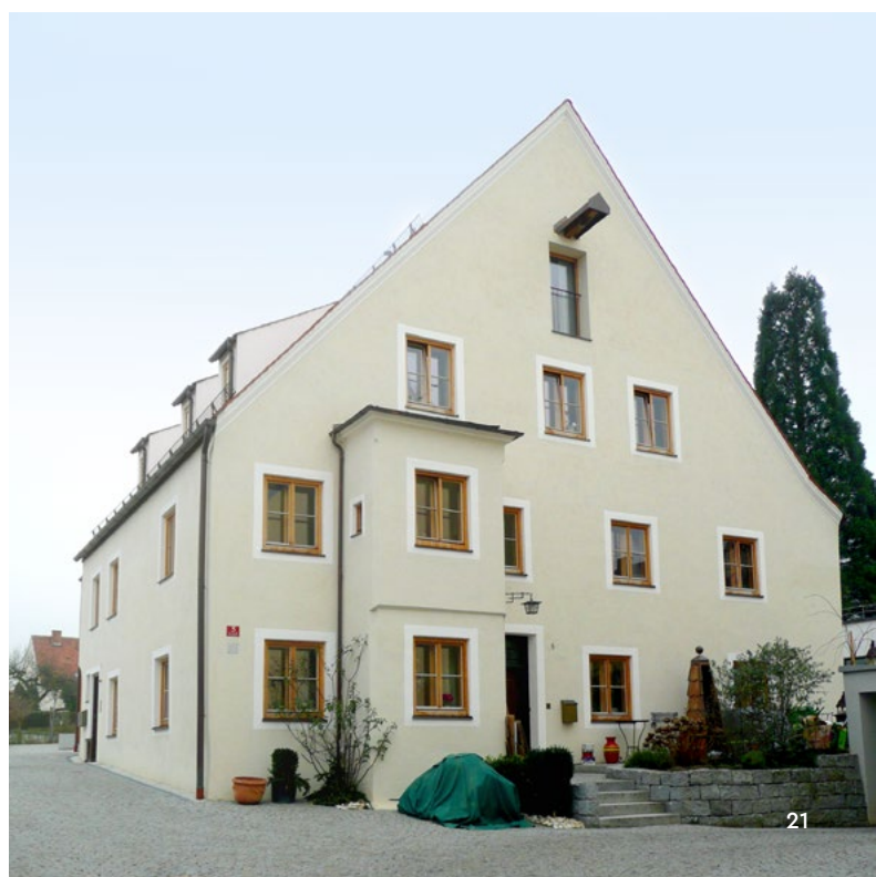
Ansicht von Osten nach der Restaurierung (Foto: BLfD, Hildegard Sahler)
