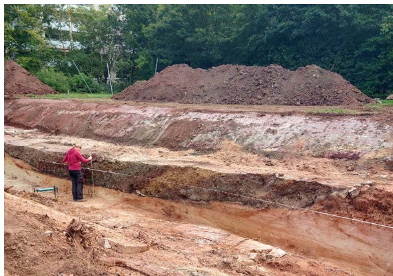
Der untere Teil des Kanalbetts im Profil (Foto: archkonzept liebte)
