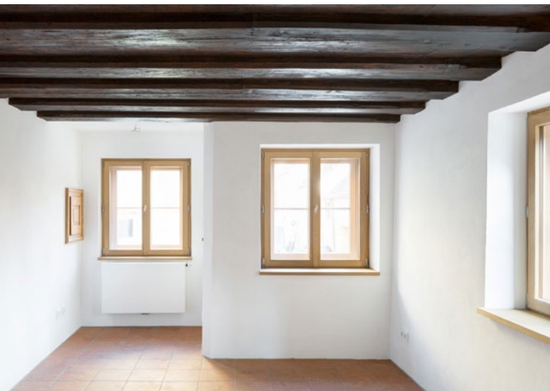
Stube im Erdgeschoss mit Bohlenbalkendecke von 1552 nach der Restaurierung (Foto: Sebastian Schels)
