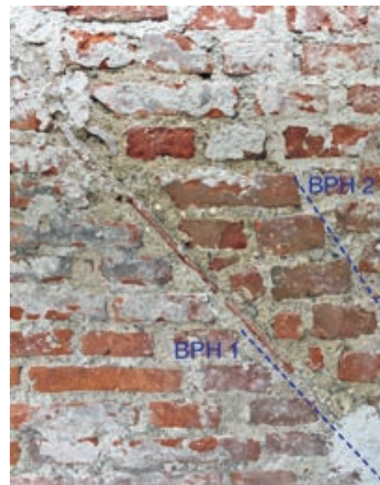
Befunde am Westgiebel nach Abnahme des Außenputzes im Zuge der Instandsetzung 2019
