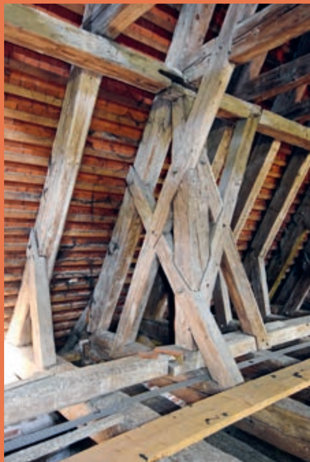
Katharinenkirche in Mühldorf am Inn, oben links: Blick in das spätgotische hölzerne Dachwerk, Übergang vom Chor zum Langhaus; oben/unten rechts: Holzkonstruktion des spätgotischen Turmhelms während der Instandsetzung (Fotos: kb-bm)
