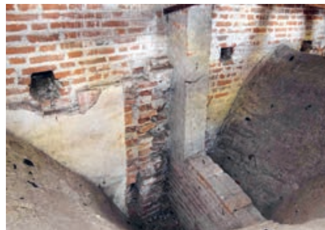
Bauhistorische Befunde an Mauern und Gewölben im Dachraum
