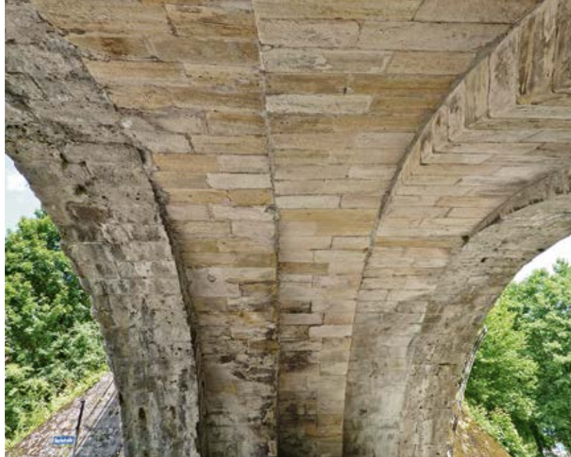
Oed, Blick in den Gewölbescheitel der Brücke mit alternierender Stufung (Foto: Mathias Conrad)
