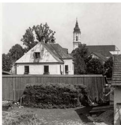
Historische Fotografien des Barth-Schlössls: links ältere Ansicht von Nordwesten; rechts Ansicht von Süden kurz vor dem Abriss 1930 (aus: Leopold Auburger, Gemeindliche Armenfürsorge in Perlach von der Dorfgmain (Gmoä) Perlach bis zur Eingemeindung nach München)
