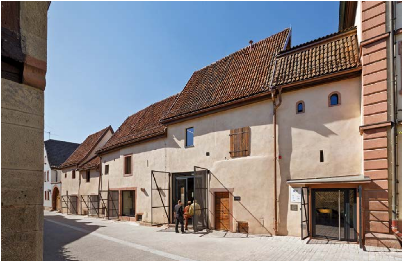
Thüngersheim, Blick auf die Kirchgaden von der Kirchgasse aus, nach Instandsetzung 2015 (Foto: Florian Hammerich)
