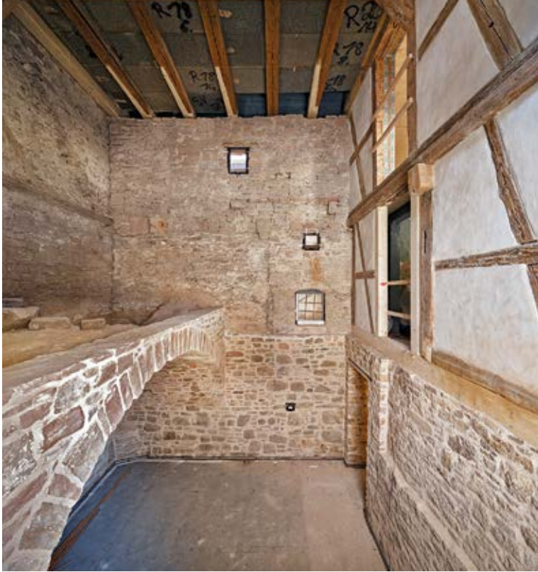
Groß wirkt der Gaden vom Keller bis unter das Dach, hier wird später die Fluchttreppe eingebaut, 2014 (Foto: Florian Hammerich)
