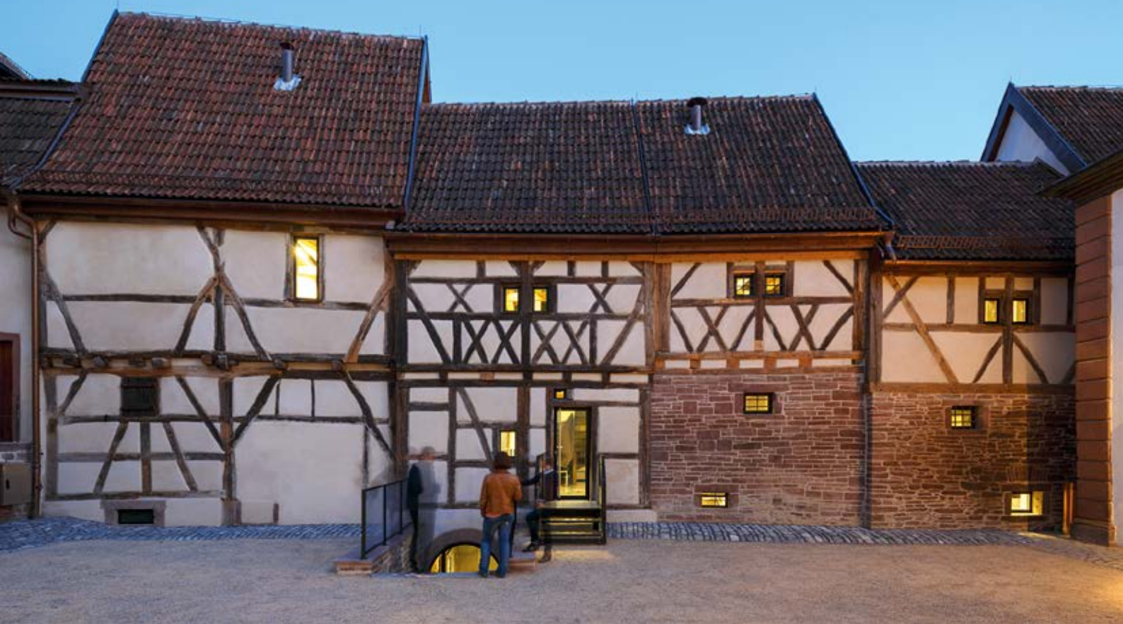
Die Gaden vom Kirchhof aus gesehen, nach der Instandsetzung 2015 (Foto: Florian Hammerich)
