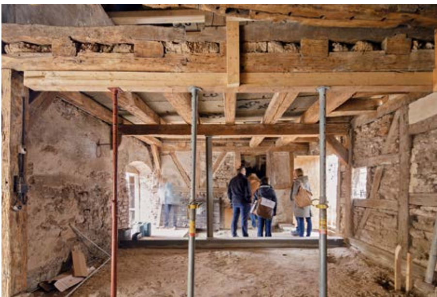
Hier wird später das Foyer entstehen – die Weingaden während der Instandsetzung, 2014 (Foto: Florian Hammerich)
