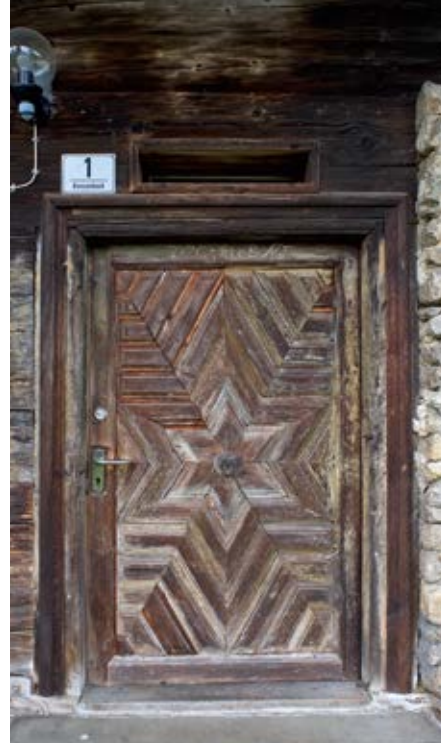
Neukirchen, Lkr. Straubing-Bogen, sternförmig aufgedoppelte Eingangstüre am Einfirsthof Dießenbach 1 (Foto: BLfD, Michael Forstner)
