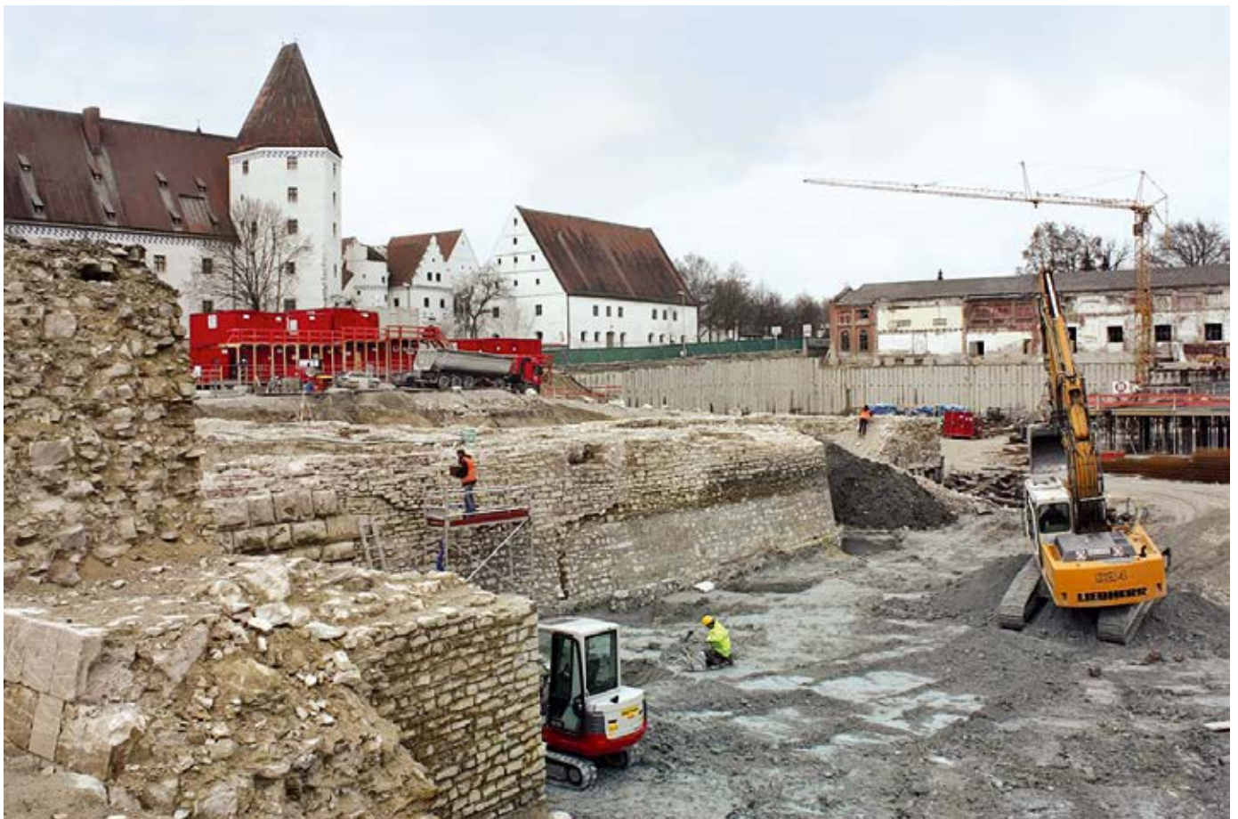
Ingolstadt, Situationsbild der Grabung auf dem Gießereigelände (Foto: BLfD, Ruth Sandner)
