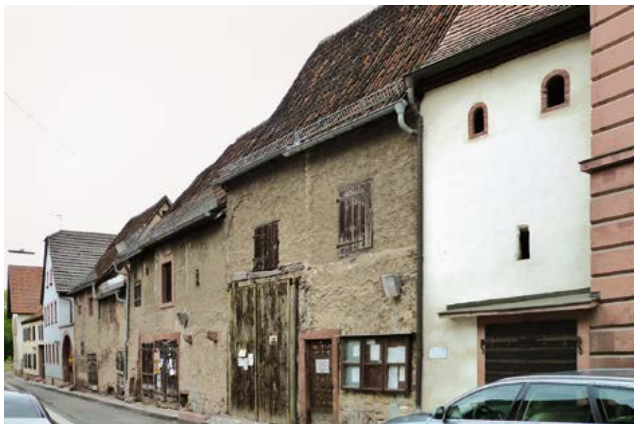
Blick auf die Gaden von der Kirchgasse vor der Instandsetzung, 2010 (Foto: Architekten Geller-Bornschlögl, Bamberg)
