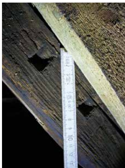
Abbildzeichen mit Kästchen. Hier der hofseitige Sparren von Gespärre Nr. 2 (Foto: Volker Rößner, 2015)
