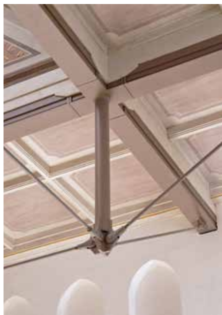
Detailausbildung eines der vier Knotenpunkte in den Kuppellecken (Foto: Peter Kifinger)
