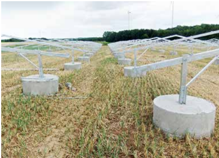
Uffenheim-Wallmersbach, Pulte auf Betonständern (Foto: BLfD, Martin Nadler)
