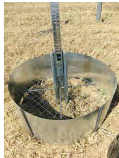
Uffenheim-Wallmersbach, Blechring als Gussform für die Betonmanschetten (Foto: BLfD, Martin Nadler).
