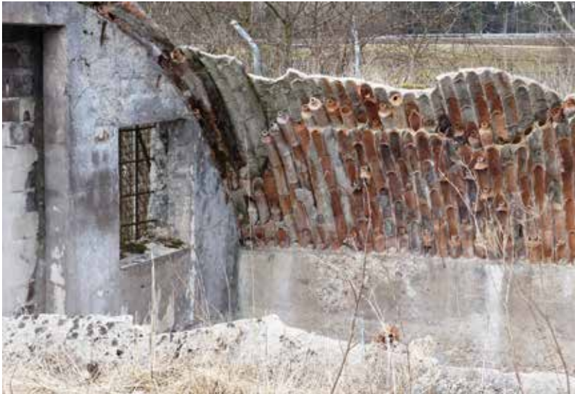
Die Ruine eines der Tonröhrenbauwerke; deren Bauweise wird hier ersichtlich (Foto: BLfD, Bernd Vollmar)
