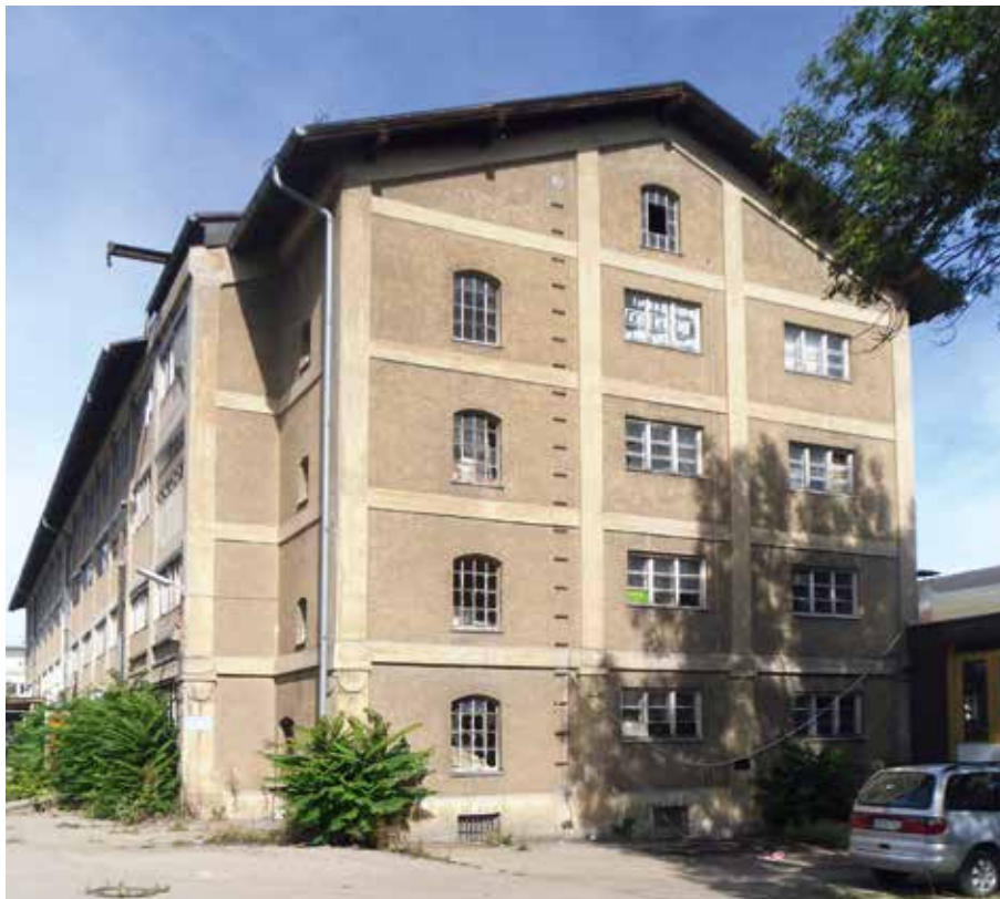
Ingolstadt, ehem. Körnerrieselmagazin, Südostfassade (Foto: BLfD)
