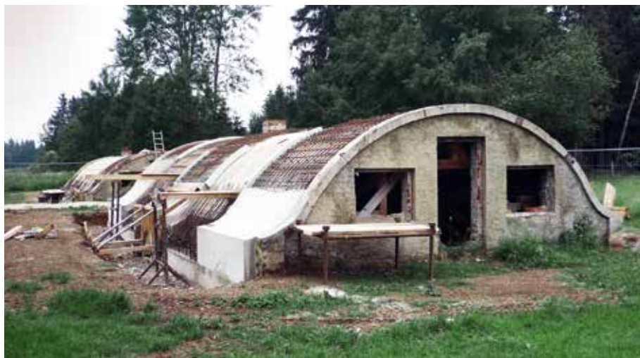
Zwei der erhaltenen Tonröhrenbauwerke im Zwischenzustand während der Aufbetonierung der neuen Betonschale (Foto: Franz Hölzl, München)
