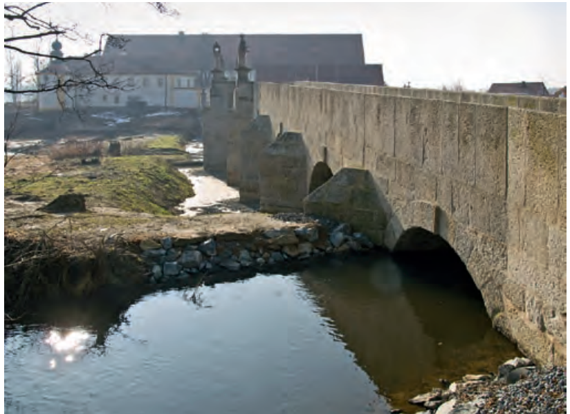
Tirschenreuth; Fischhofbrücke (Foto: BLfD, Eberhard Lantz 0611103008, 2011)
