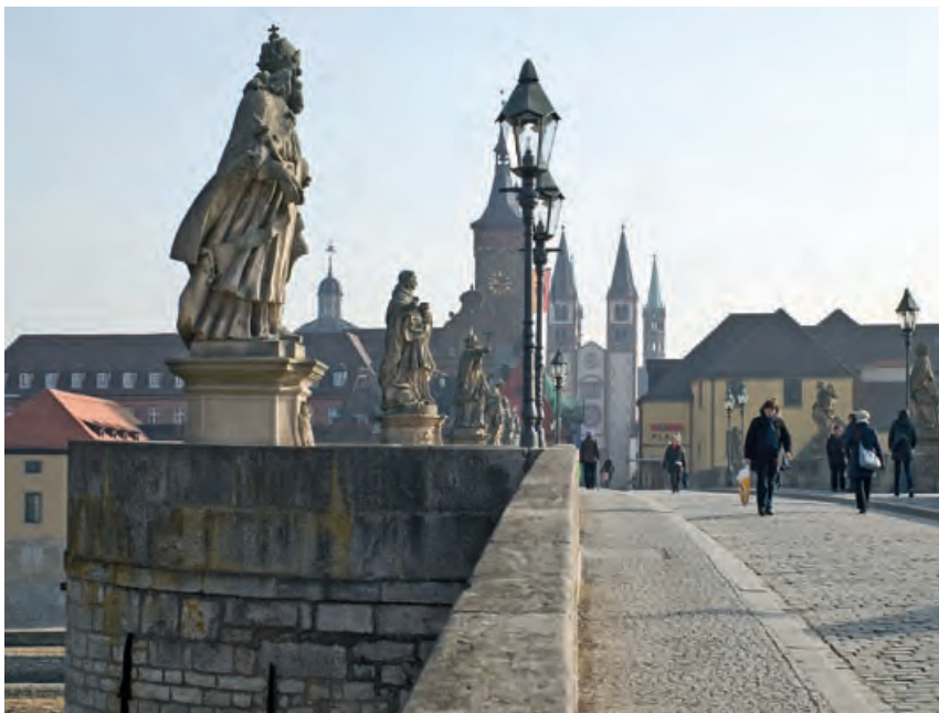
Alte Mainbrücke (Foto: BLfD, Eberhard Lantz 0611102059, 2011)
