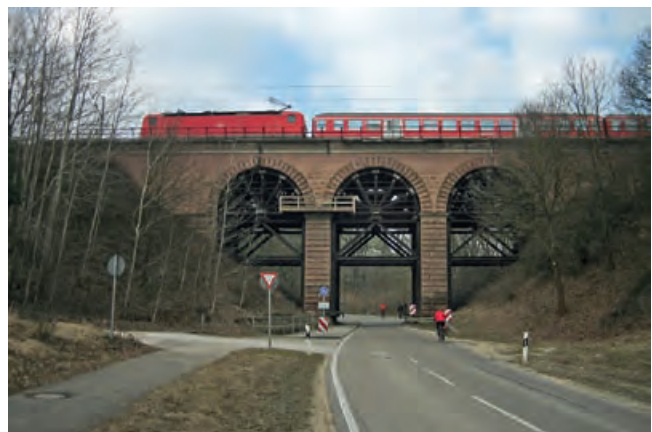
Höhbach-Viadukt bei Pleinfeld, Lkr. Weißenburg-Gunzenhausen; seit 1984 mit statischem Schutzgerüst (Fotos: BLfD, Ulrich Kahle; Aufn. oben aus dem Jahr 1980, Aufn. unten 2011)
