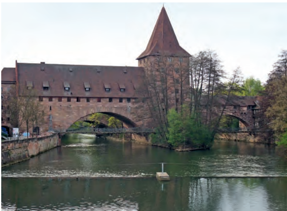
Kettensteg, Gesamtansicht (Foto: BLfD, Uli Walter, 2011)
