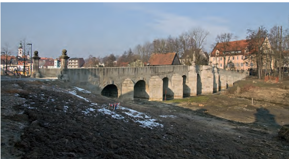
Fischhofbrücke, Gesamtansicht (Foto: BLfD, Eberhard Lantz 0611103006, 2011)
