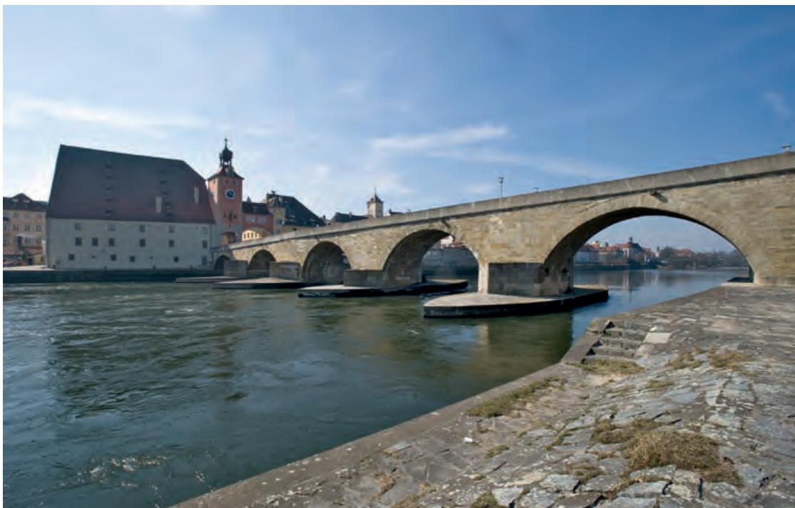
Steinerne Brücke (Foto: BLfD, Michael Forstner 11004342, 2011)
