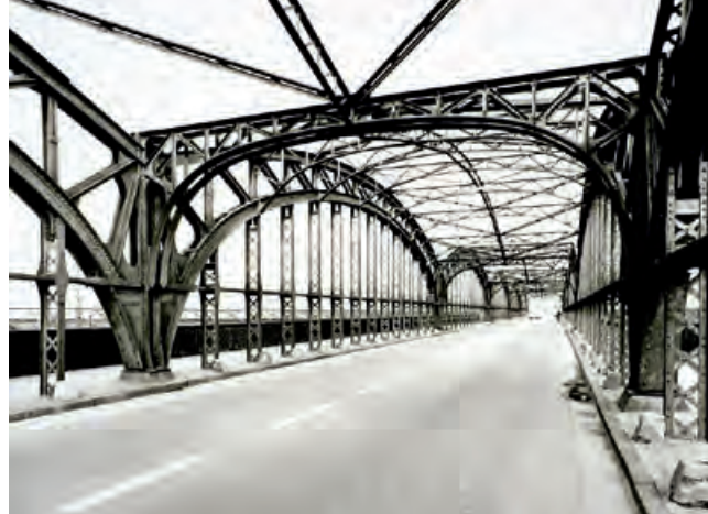
10. München; Hackerbrücke (Foto: BLfD, 1981)
