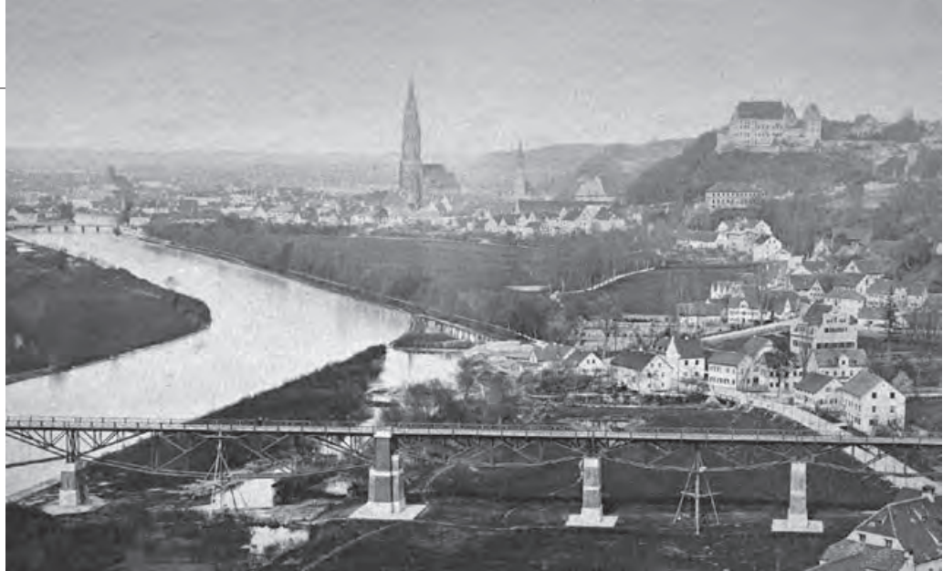
Oben: Landshut; Eisenbahnbrücke über die Isar in Fachwerkstahltechnik, errichtet 1882 im Rahmen des Ausbaus des Schienenverkehrs von Landshut über Neumarkt-St. Veit nach Isen (Foto: BLfD 02023674, Albuminpapier, Frühjahr 1882)
