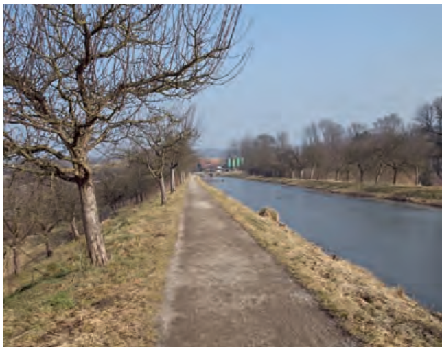
5. Burghthann, Lkr. Nürnberger Land; Distellochdamm des Ludwig-Kanals, 1849 (Foto: BLfD, Eberhard Lantz, 2011)
