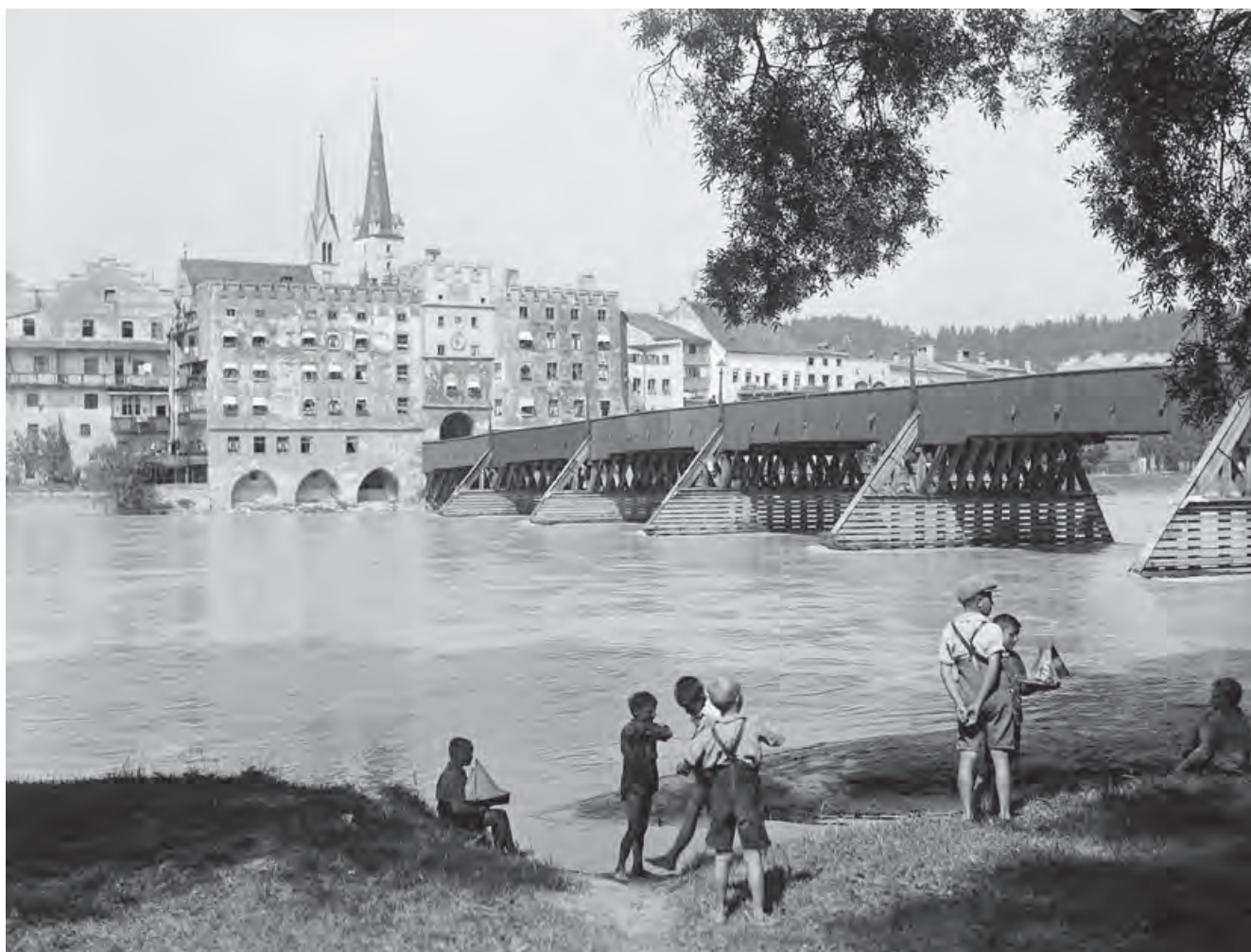
Wasserburg a. Inn, Lkr. Rosenheim; hölzerne Innbrücke am Brucktor (Foto: BLfD 01065217, Gelatinetrockenplatte, Carl Stechele, um 1930)
