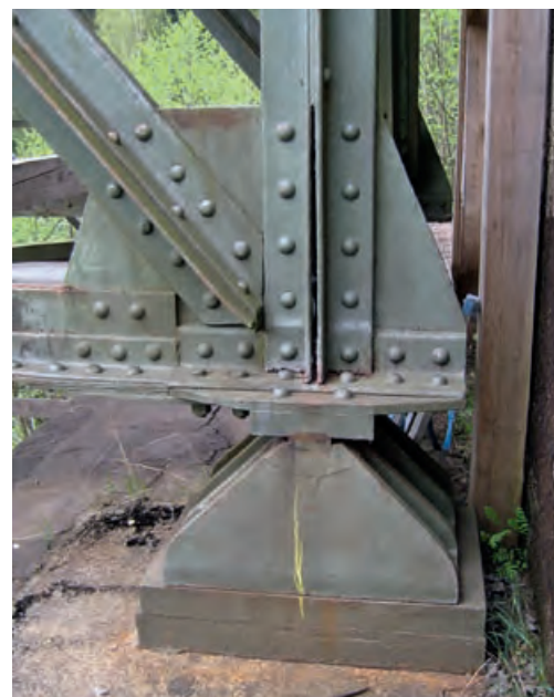
Deffernikbrücke; Auflagerpunkt des Fachwerkträgers auf dem südlichen Widerlager, mit Knotenblech und zusammengeklebten Stahlprofilen (Foto: BLfD, Julia Ludwar, 2011)
