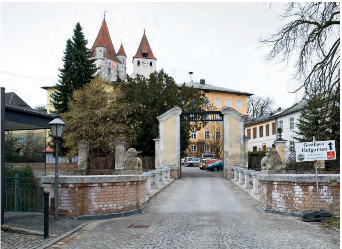
Löwenbrücke (Foto: BLfD, Michael Forstner 1595, 2011)
