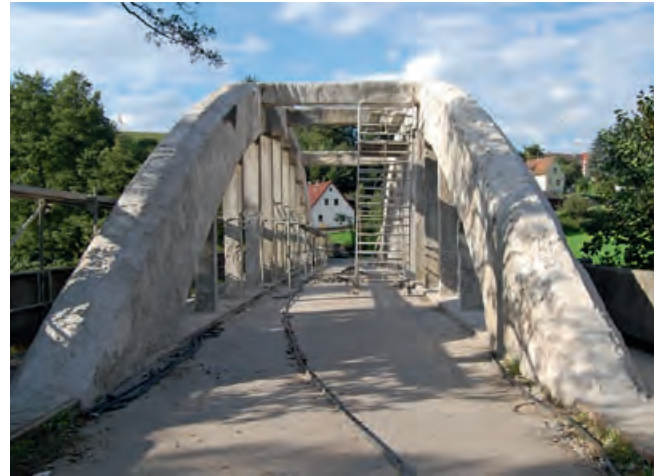
Pfreimd-Brücke während einer Zustandsuntersuchung (Foto: Leo Berberich, 25.08.2010)
