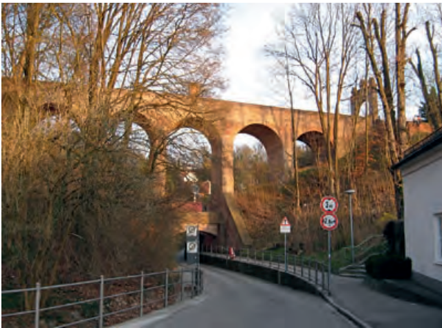
Dingolfing, Lkr. Dingolfing-Landau; Hochbrücke (Foto: Michael Schmidt)
