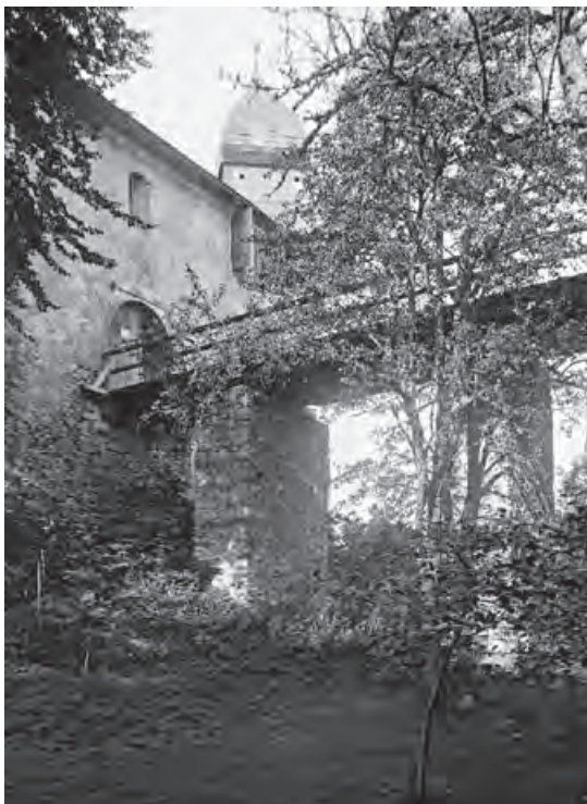
Unten: Schloßprunn, Stadt Riedenburg, Lkr. Kelheim; Holzbrücke auf gemauerten Pfeilern über den Halsgraben von Schloss Prunn (Foto: BLfD AM2009-12-10-01029550, Gelatinetrockenplatte, um 1925)
