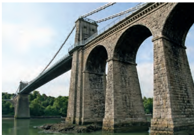
4. Bangor, Wales; Menai-Bridge von Thomas Telford, gilt als erste moderne Hängebrücke der Welt, 1826 (Foto: Gerhard Ongyerth, 2008)
