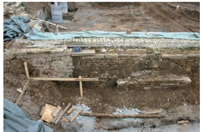
Baufuge am ersten Pfeiler der Brücke zum Spitaltor hin während der Aus- grabung 2008 (Foto: BfAD Heyse Schwarzach)
