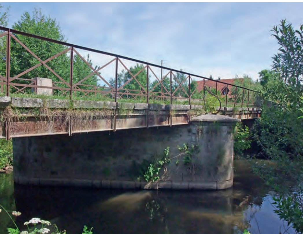
Obere Brücke von Südosten (Foto: BLfD, Christian Schmidt, 2010)
